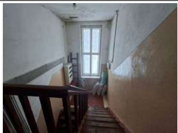
2.stāva kāpņu telpa
