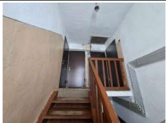
2.stāva kāpņu telpa
